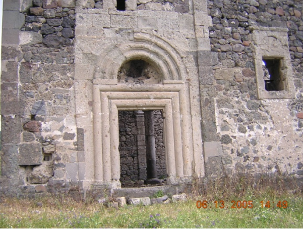
Kutlukent Altinkaya Kilisesi
