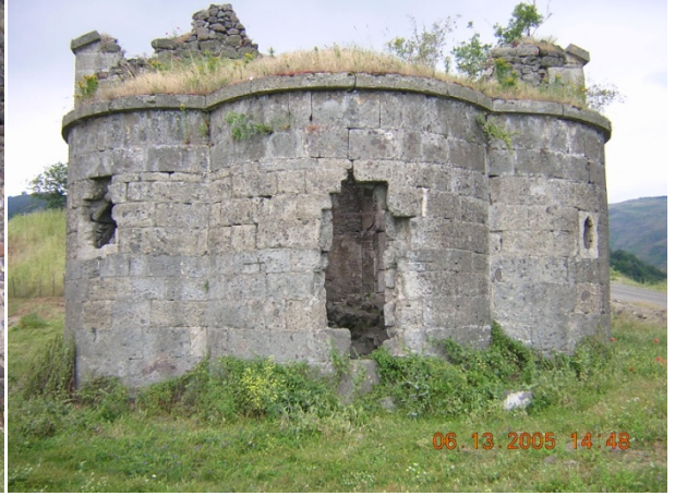
Kutlukent Altinkaya Kilisesi
